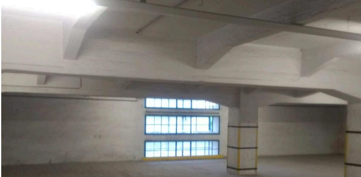
Abb.18: Stahlbetonrahmen mit Haupt- und Nebenträgern, Magazin 2, Blick nach Nordwesten (ILG, Abt. PE)
