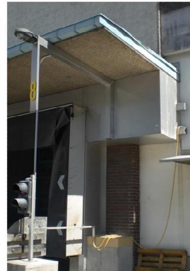
Abb.14: Sockel mit verbliebenem Klinkereck (ILG, Abt. PE)
