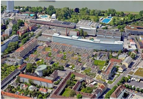
Abbildung 44: Der lang gestreckte Bau 1 der Tabakfabrik wird etappenweise adaptiert © Stadtplanung/Pertlwieser
