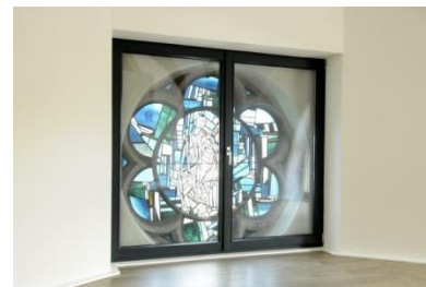
Abbildung 10: In diesem Fall blieb das Buntglasfenster hinter dem neuen Fenster erhalten.
